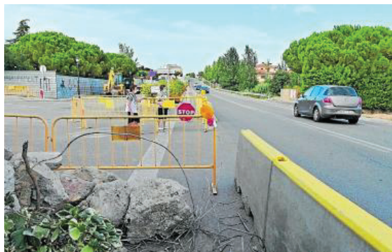
Aquesta setmana han començat els treballs de construcció de la nova rotonda. FOTO: ALFREDO GONZÁLEZ
